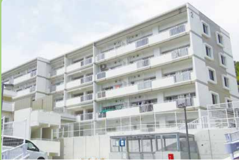
鹿野復興公営住宅（太白区）
