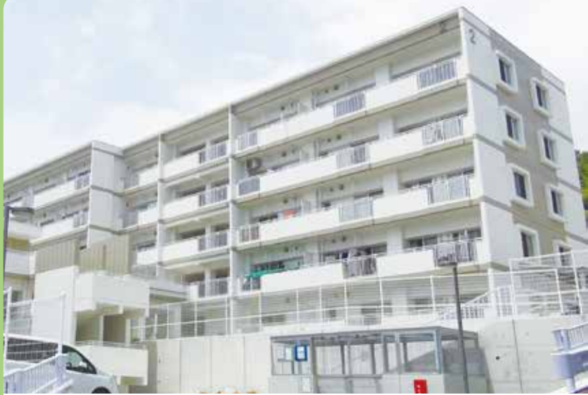
鹿野復興公営住宅（太白区）
